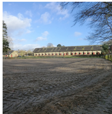
Entrée en fonction en 1881, l'écurie numéro 4 dite de "l'infirmerie" du Haras National d'Hennebont dispose de 11 boxes.
