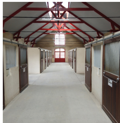
l'écurie numéro 5 dispose de : 16 Boxes de 10,5 m 2 , d'un solarium, d'un tapis de marche ...
