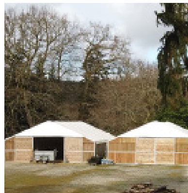
Installation en bois temporaire, deux barns viennent s'ajouter à l'ensemble des écuries.
